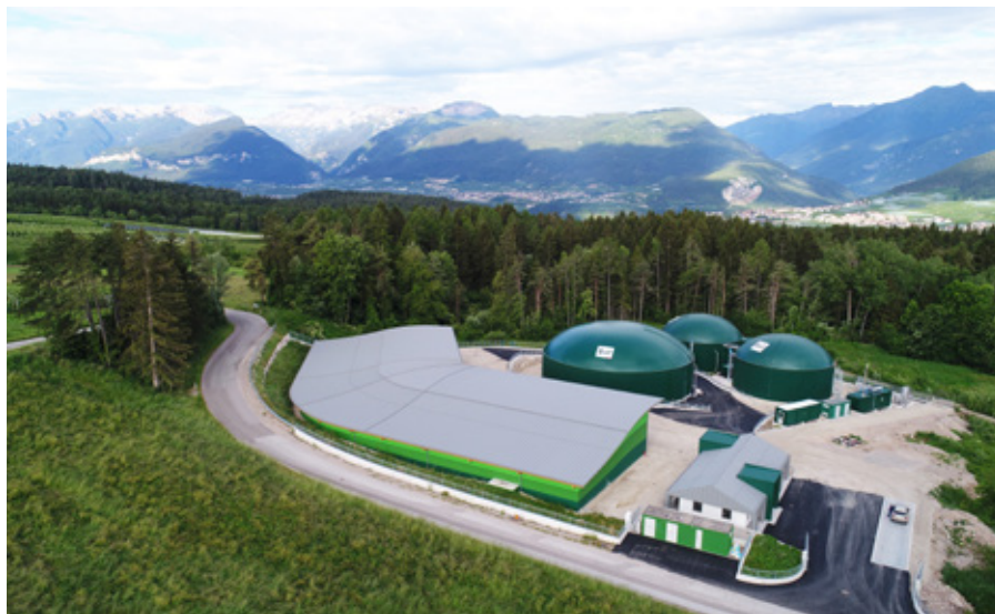
Una veduta del biodigestore consortile di Romeno
